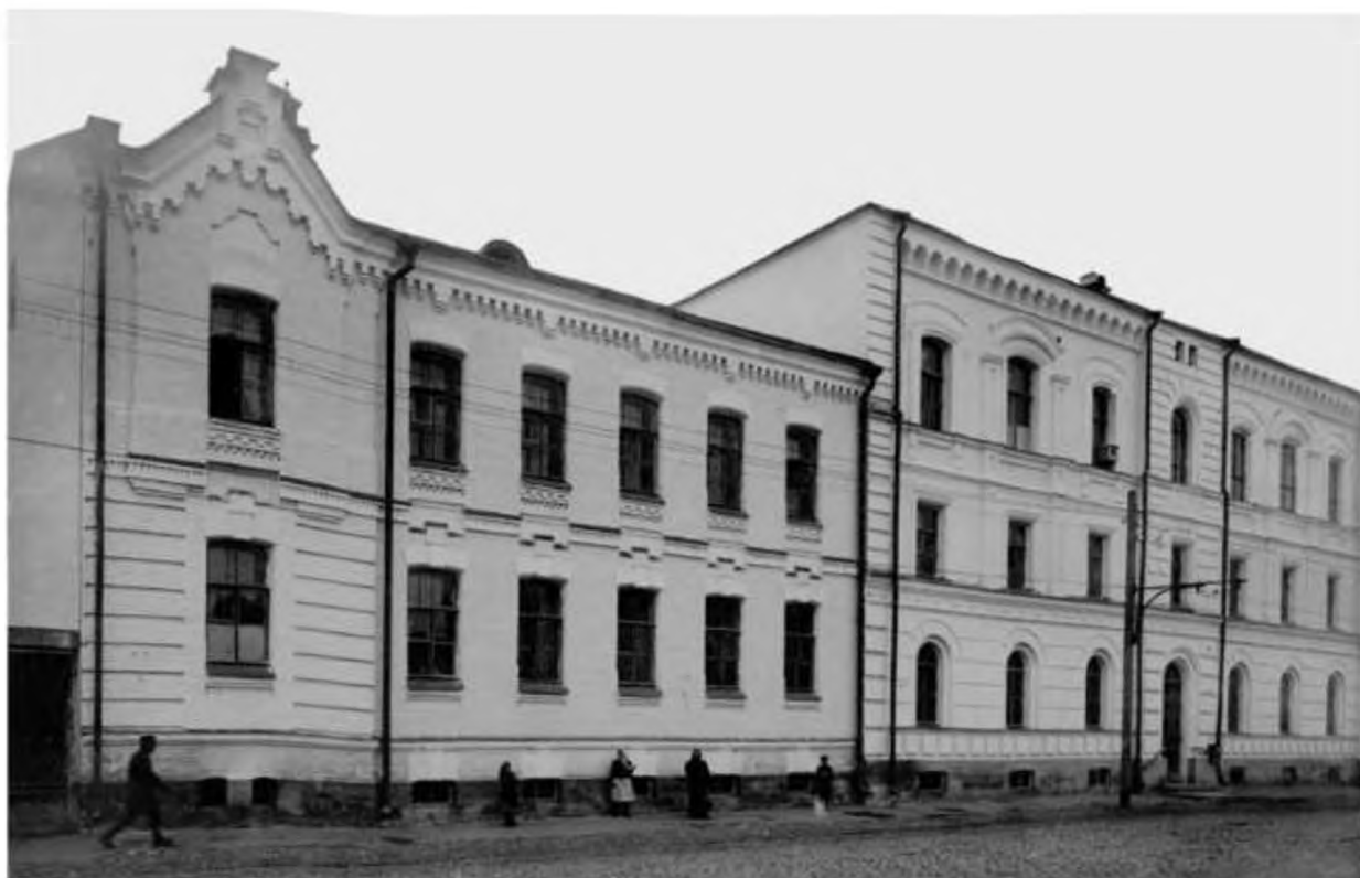
Рис. 14.а. Здание по ул. Трехсвятская 31/16.
