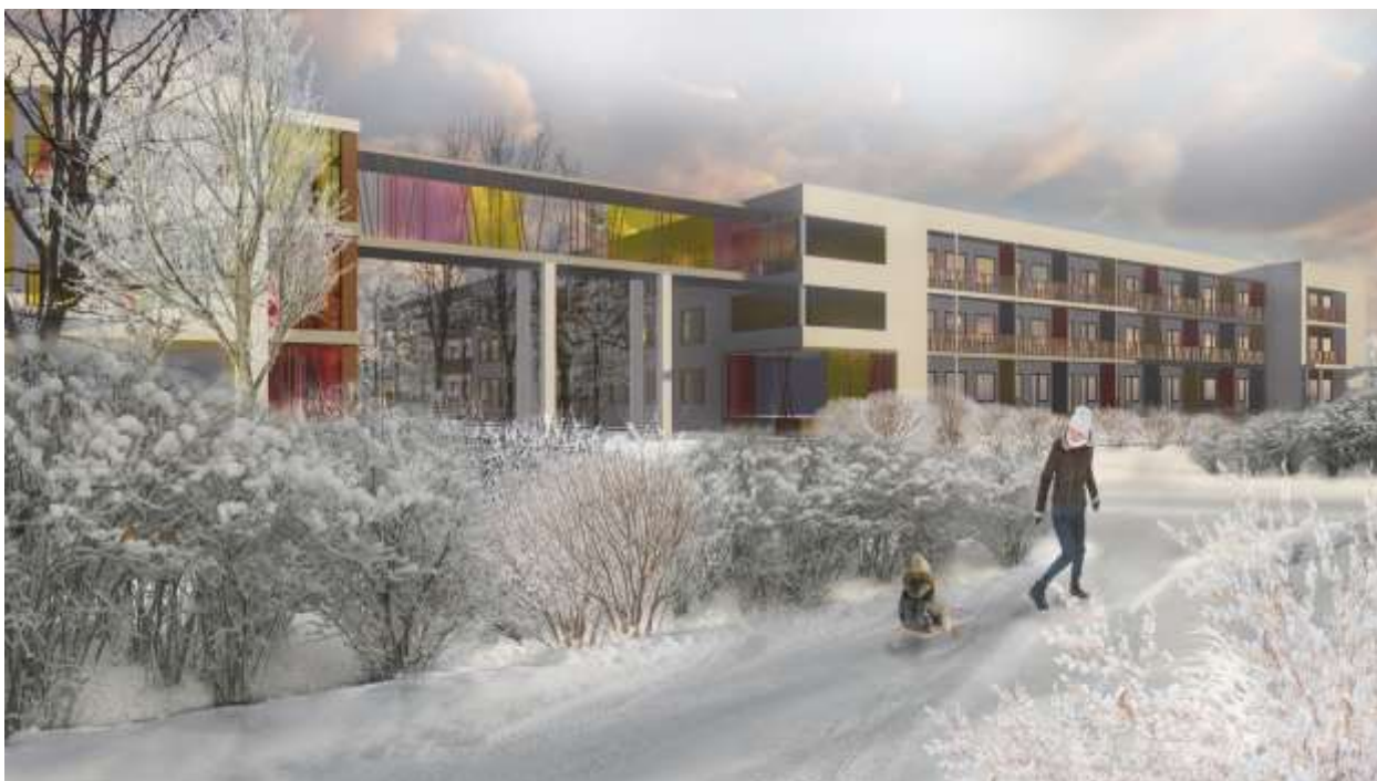
Общий вид зданий с мостом-переходом над Полевой улицей зимой.
